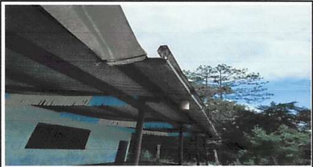
Foto 2: como se puede observar, canal en mal estado por el tiempo y el deterioro necesita cambio por a ver cumplido su vida util ✓
